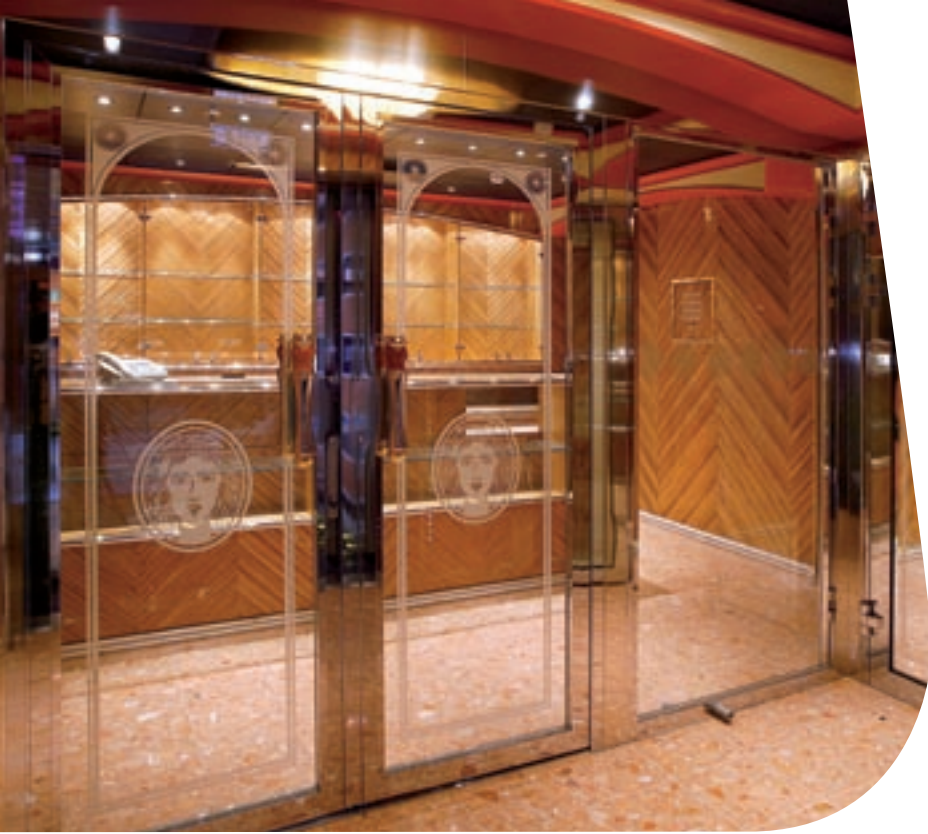
Laiva Carnival Miracle: Hiekkapuhallettu Pilkington Pyrodur™ , laivakäytön (IMO) B15 vastaa lähinnä E 30/EI 15.
